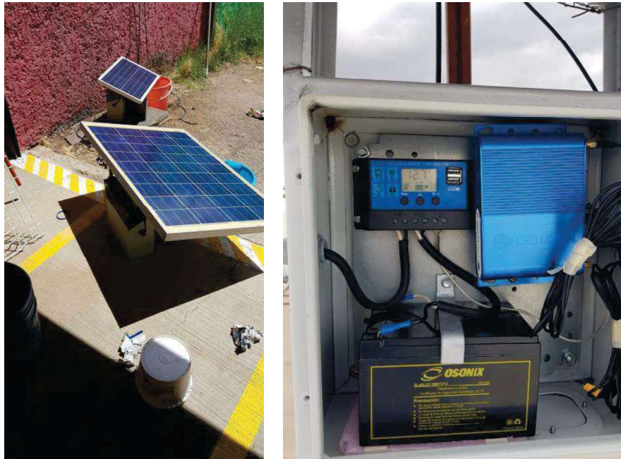
Figura 9. Instalación del equipo electrónico y Gateway (Derecha) y el panel solar (izquierda).
