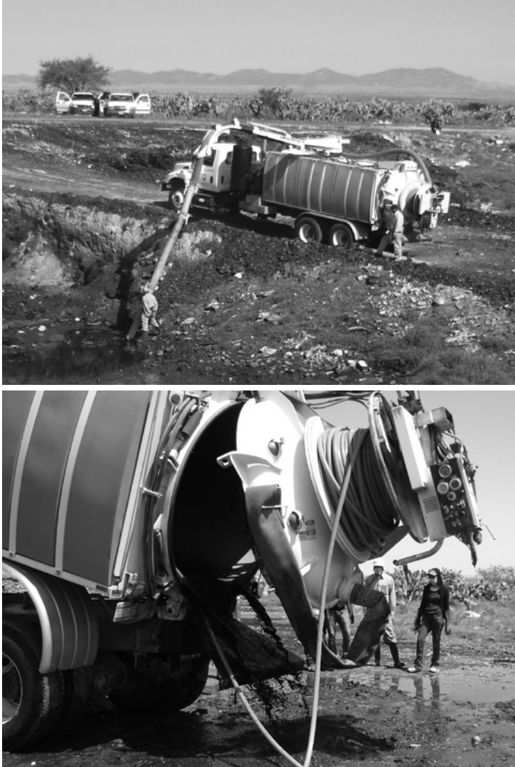
Foto 3. Uso del camión Hidroneumático Acuatech para desazolve
