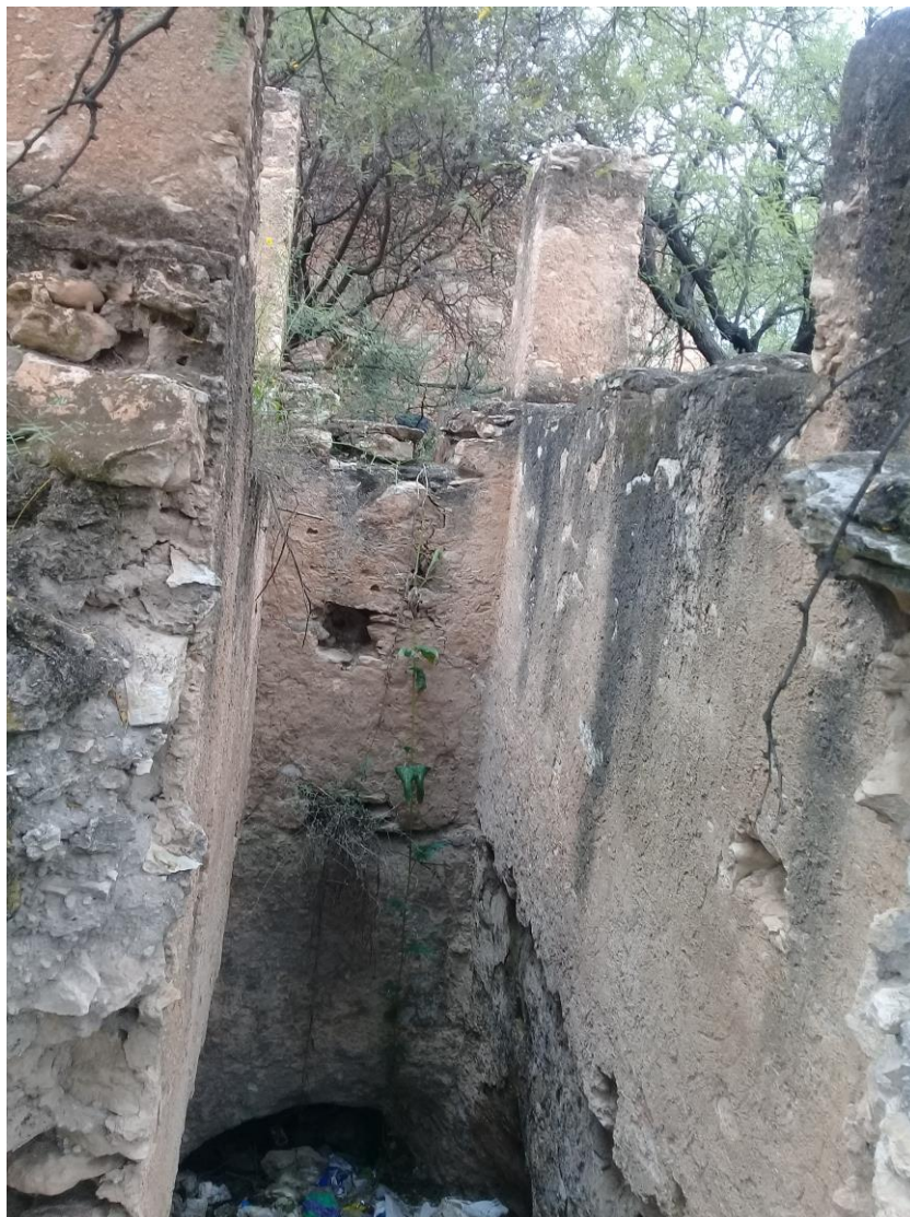
Ilustración 36 Estructura pozo profundo que conecta las estructuras, Probable filtro para lodos. Efraín Pérez Cabral, noviembre de 2018.
