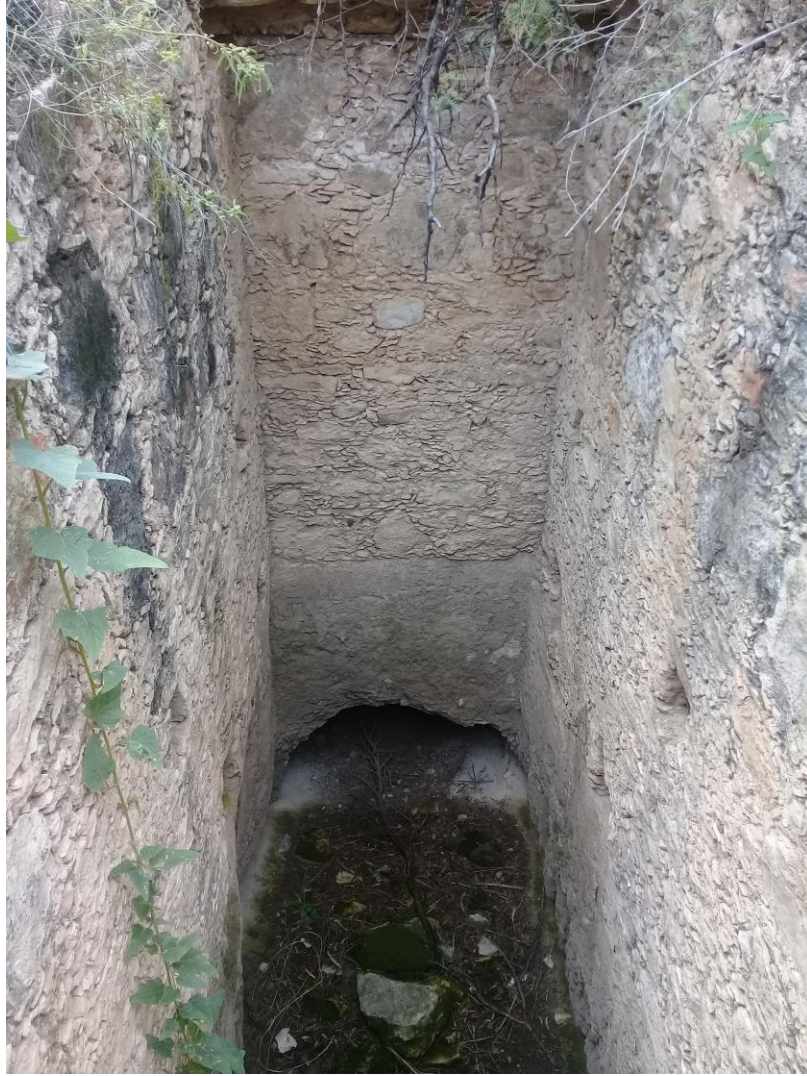
Ilustración 34 Pozos profundos quizás empleados como filtros para la limpieza del agua salina.
