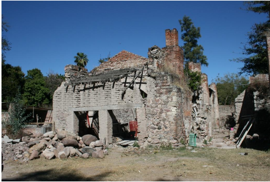
Fotografía 2: Sala de las calderas en La Mezquitera Norte. FMM 2007.
