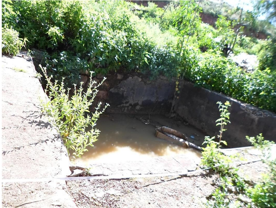
Figura 117: Vista de una de las pilas de la huerta, en donde se observan dos fases de construcción la primera a base de piedra riolítica y una posterior de mantenimiento con cemento.
