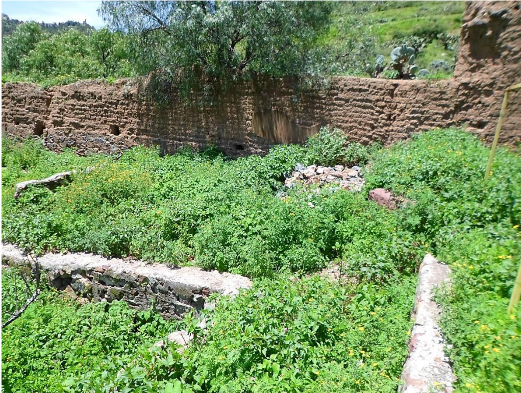
Figura 115: Represa construida a base de piedra de mina que se relaciona con un alineamiento de rocas que marca el inicio de la unidad 4 y que tiene que ver con un desnivel del terreno, lo que favorece la distribución de agua al interior de la huerta.
