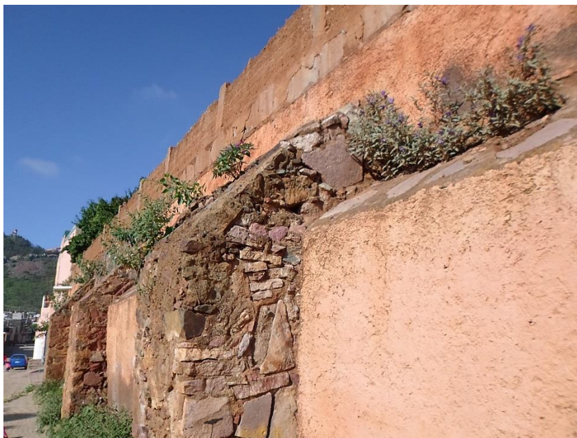
Figura 99: Vista del sistema constructivo de la Huerta de La Pinta a base de contrafuertes.
