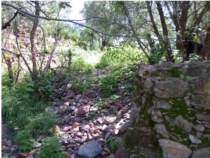
Figura 125: Vista del tipo de materiales y estructuras asociadas a la tercera fase constructiva.
