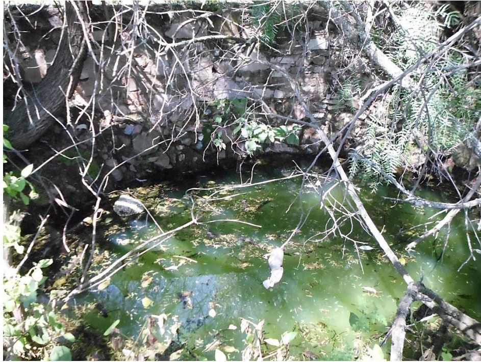
Figura 111: Ojo de agua dentro de la huerta, se observa al fondo construcción de muro perimetral de Las Mercedes.
