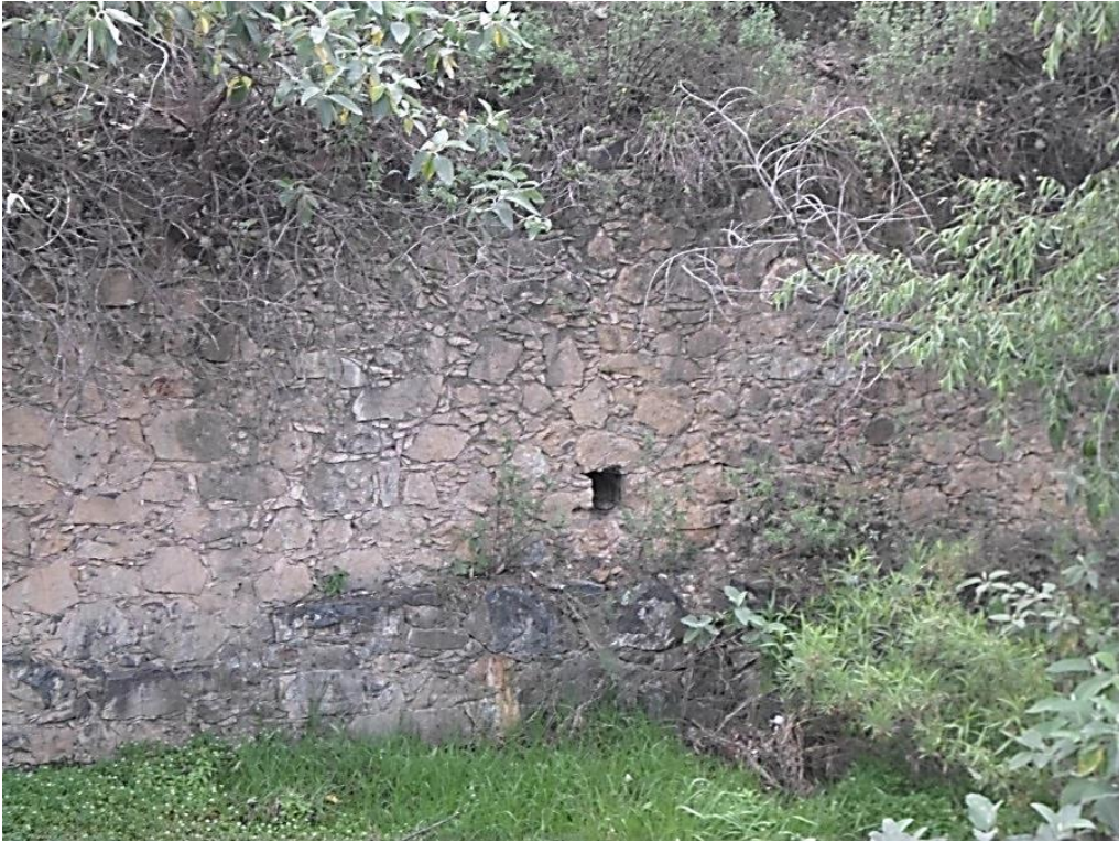
Figura 53: vista de muro con liberador de presión
