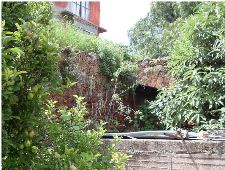
Figura 103: Vista de una de las pilas de la huerta de La Pinta asociada a una construcción propia del beneficio de metales
