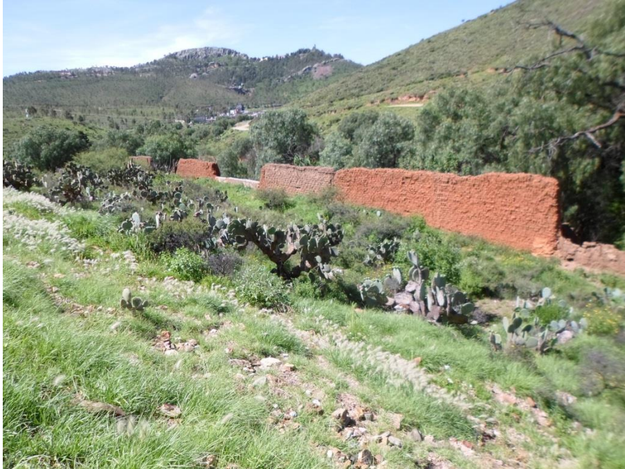
Figura 124: Vista de los dos tipos constructivos, destaca el adobe rojizo de la segunda el cual es deleznable y de mala calidad.
