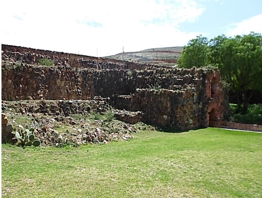
Figura 59: Vista del sistema constructivo de la presa de Bernárdez
