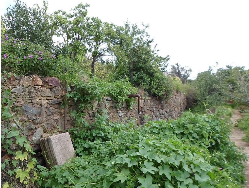
Figura 95: Vista del sistema de terrazas interiores de la Huerta de La Pinta, construidas a partir de piedra de mina.
