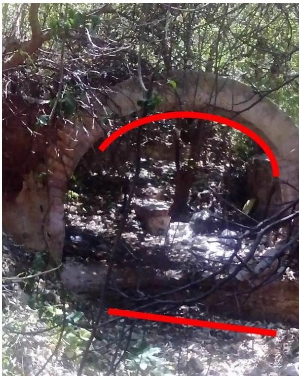
Figura 86: Vista de vestigios asociados a la noria ubicada al lado de la Casa Grande de la Huerta del Padre Castillo, destaca arco y alineamiento.
