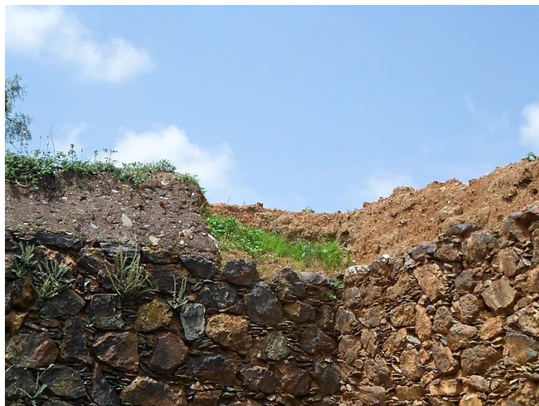
Figura 148: Detalle de muro donde destaca el tipo de construcción como la materia prima (base piedra de mina y remate con adobe)
