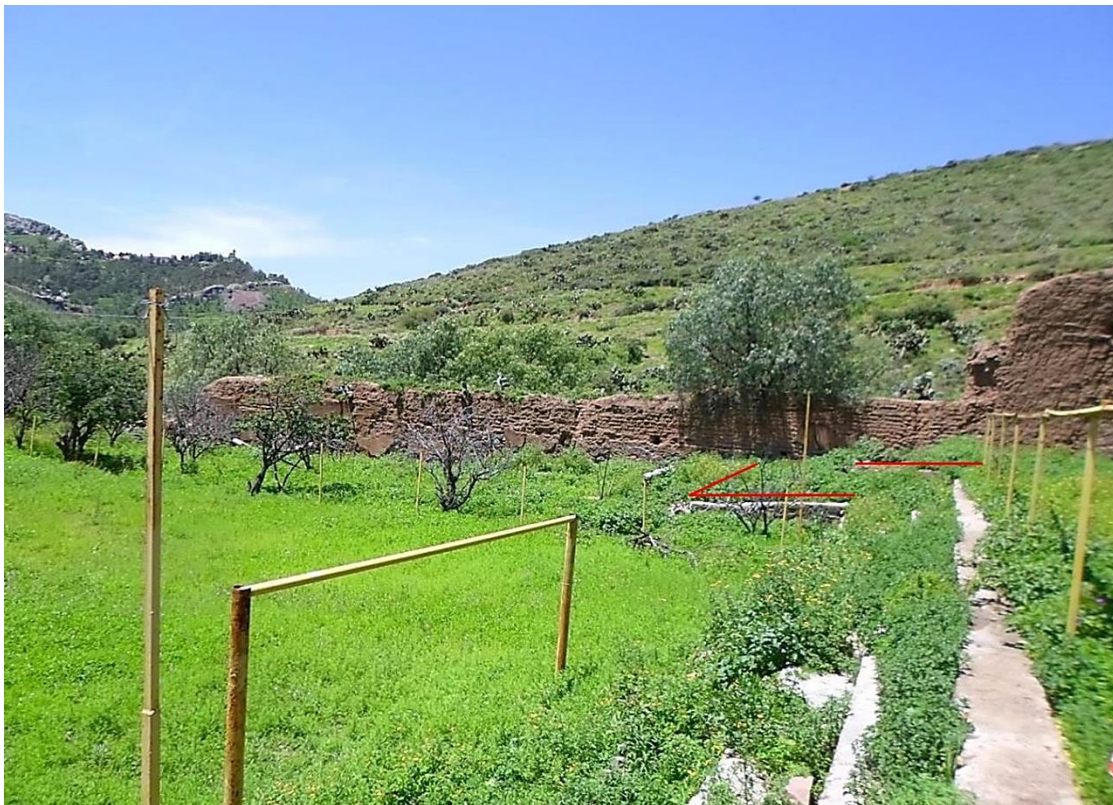
Figura 114: Vista de pequeña represa que permite la acumulación de agua y a través del alineamiento (a base de piedra de mina) la redistribución del líquido, posteriormente se adaptó como bancas para cancha de futbol.
