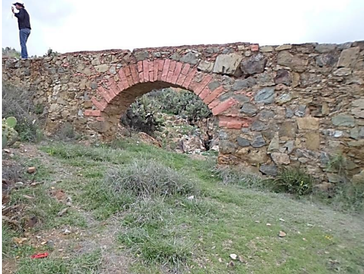
Figura 47: Vista del acueducto donde se observan las fases constructivas y un arco.
