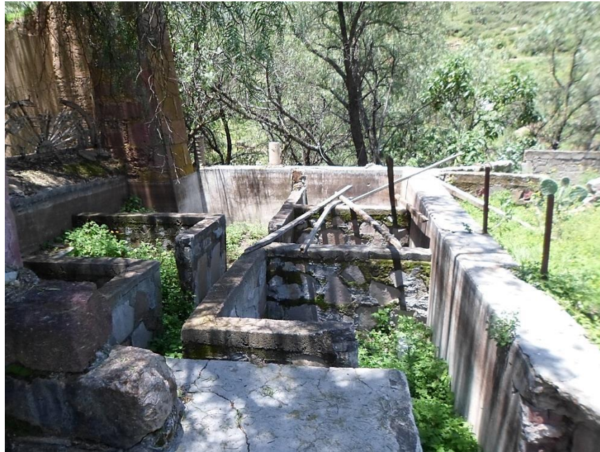
Figura 126: Vista de combinación de materiales constructivos, énfasis en la presencia de estructuras metálicas
