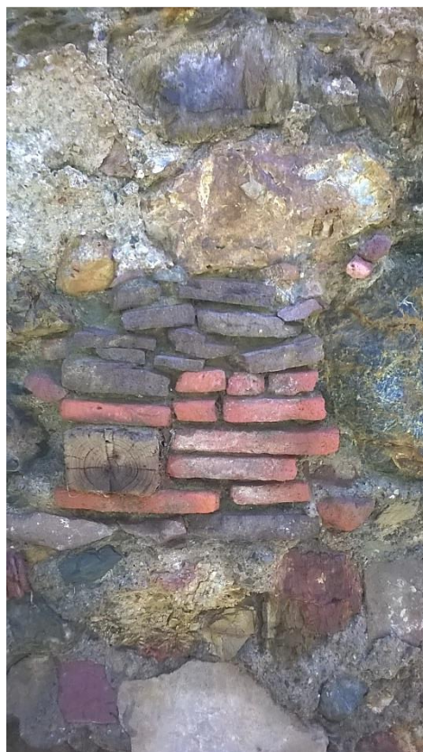
Figura 127: Muro donde se perciben varias de las fases constructivas que se dieron en la huerta de las Mercedes.
