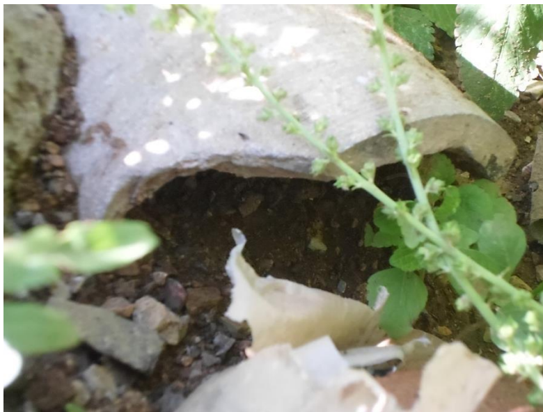
Figura 116: Vista de tuberías de concreto
