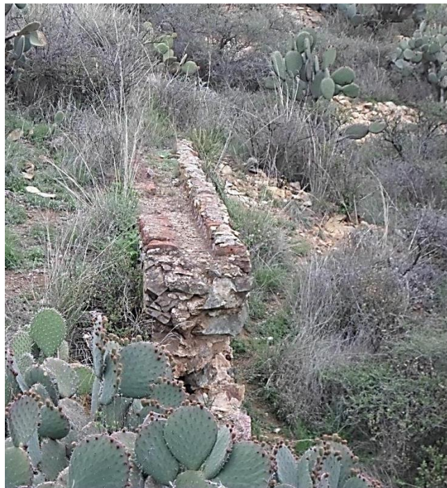
Figura 48: Detalle del canal por donde pasaba el agua.
