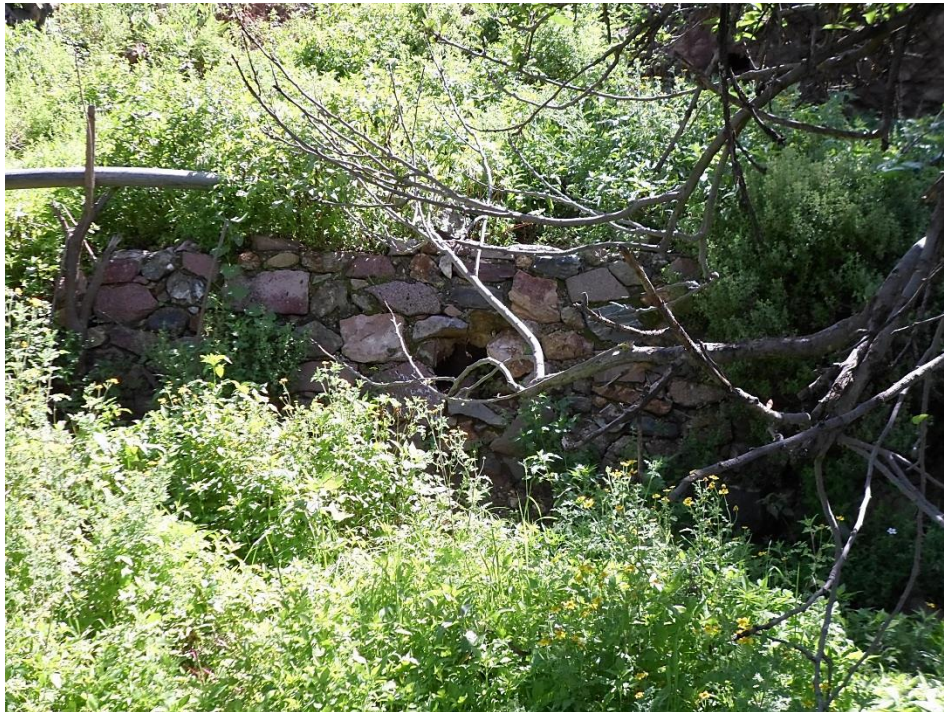
Figura 123: Construcción de terrazas de la primera etapa.
