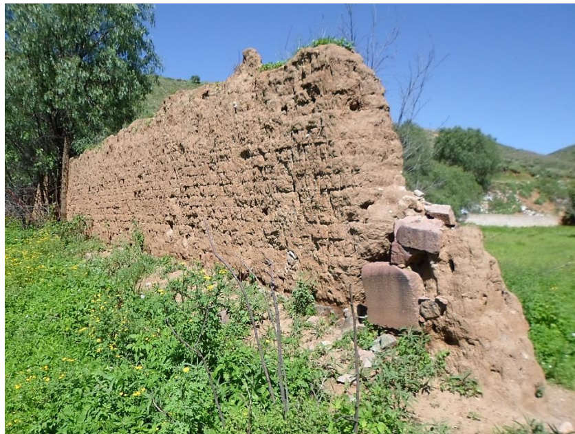
Figura 121: Vista de uno de los muros que separa una unidad de trabajo de otra, en el cual se observa una base de piedra sobre el que se construye un muro de adobes compactos y de buena calidad.
