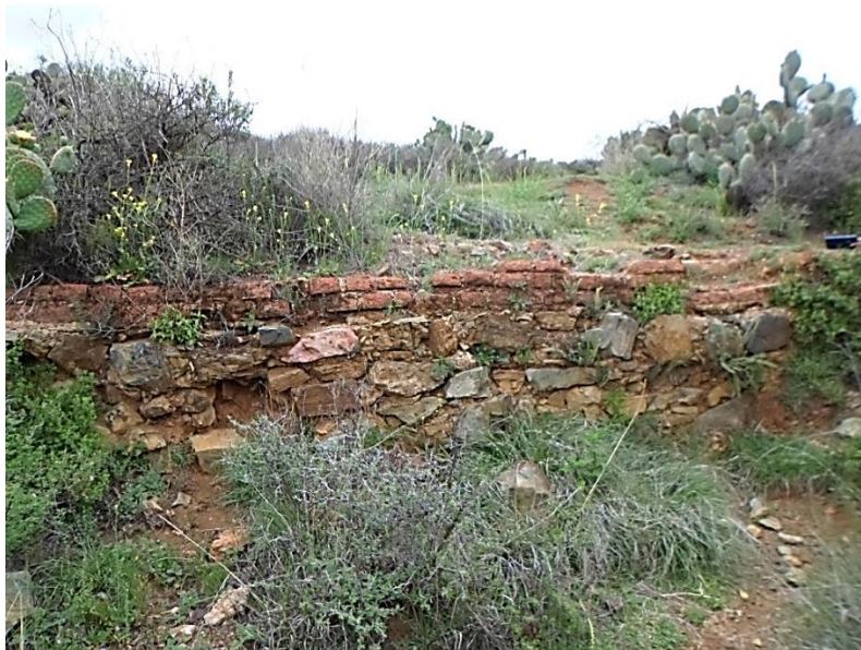
Figura 46: Muro de acequia, donde se observan dos fases constructivas.
