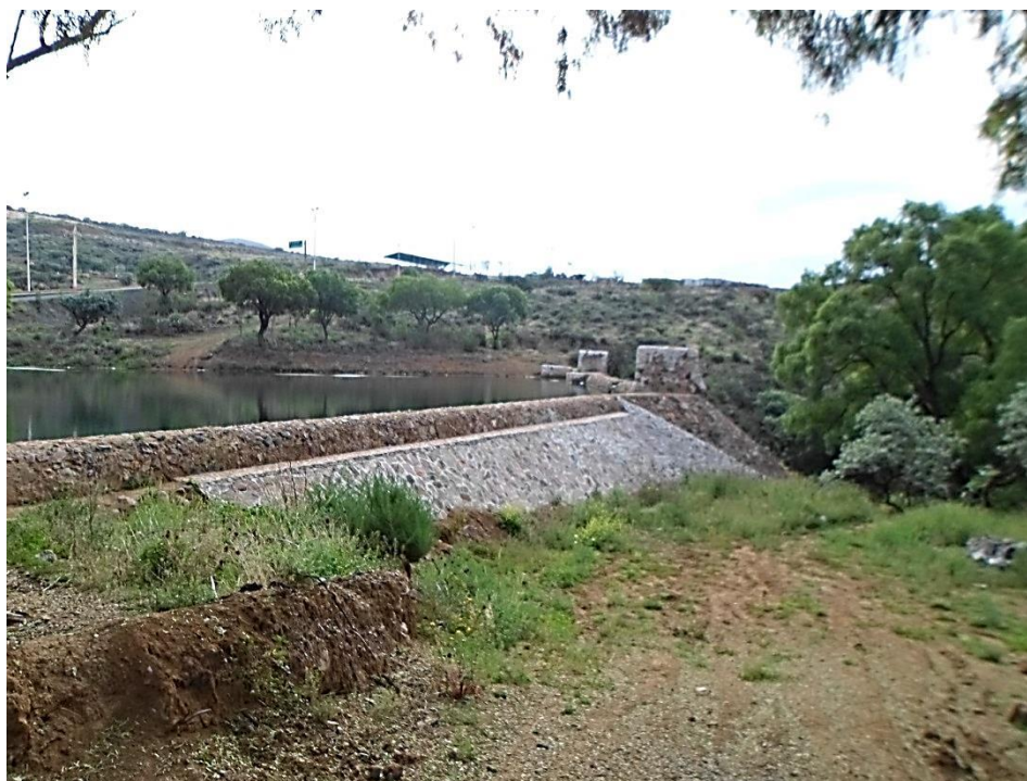
Figura 51: Vista de la primera cortina de la presa, de elaboración reciente.
