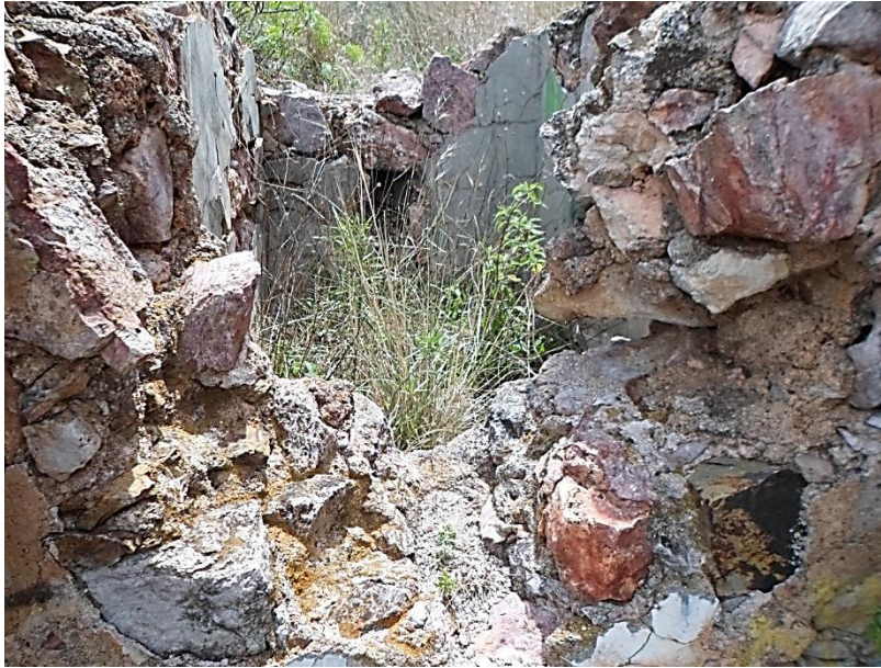
Figura 61: Vista de procesos de mantenimiento y conservación de la presa.
