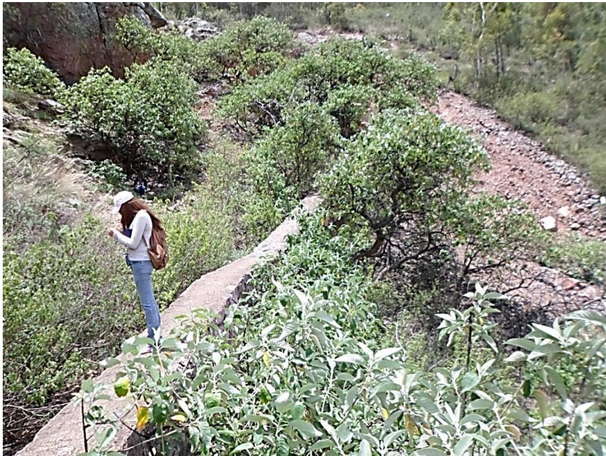
Figura 62: Segunda obra de contención, cortina de mampostería.
