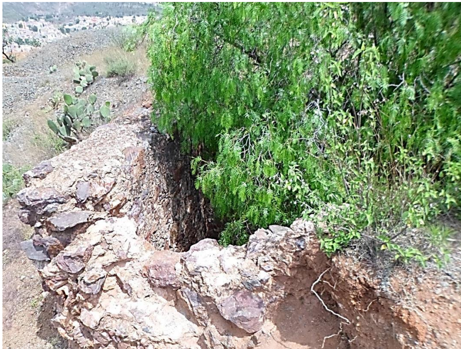
Figura 60: Vista del muro que representa una fase en la contención.
