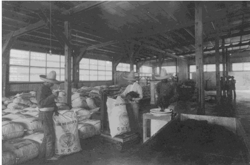
Fotografía 28: Encostalado de caucho.
