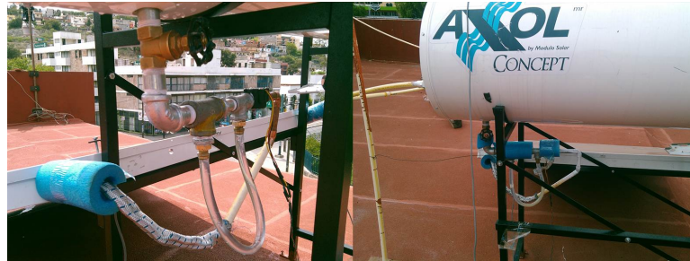
Figura 3.18 Sensor YF-21 adaptado al sistema.
