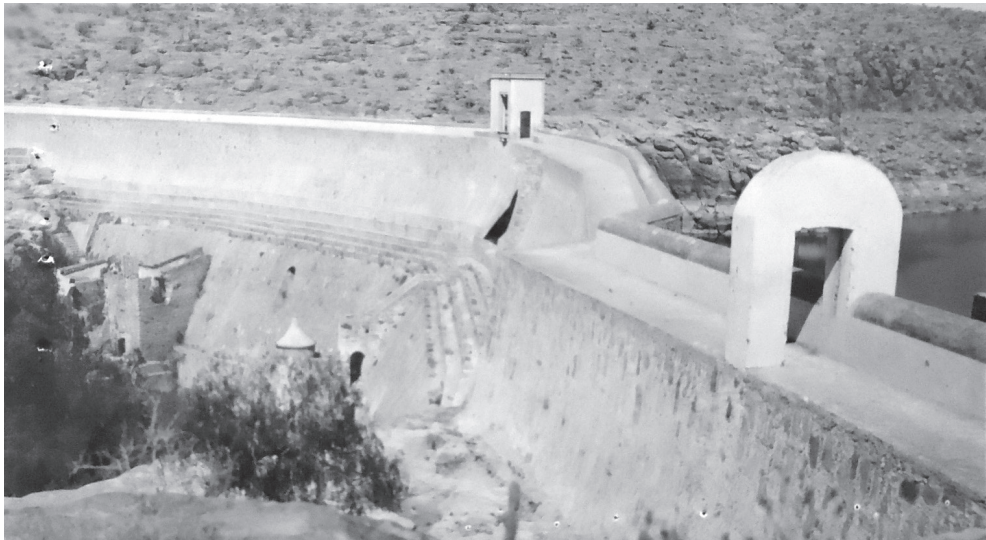
IMAGEN 1. Finca (página anterior), anexos y presa grande, ex-hacienda de San Marcos, Bimbaletes. Fuente: AHSEP, Fondo Departamento de Enseñanza Agrícola y Normal Rural, Serie Escuela Regional Campesina Bimbaletes, Zacatecas, Caja 33477, «Fotografías sobre informe de visita a la Hacienda de San Marcos, Bimbaletes», marzo 1 de 1933.
