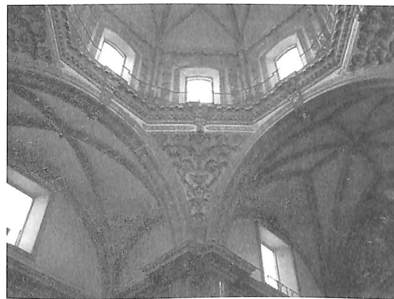
Vista interior. Cúpula y pechinas en crucero.
