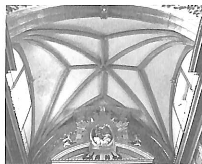
Bóveda nervada, detalle sobre altar mayor.
