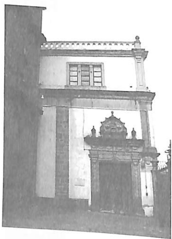
Fachada lateral, vista al poniente.
