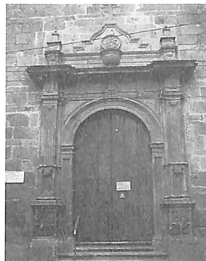
Puerta lateral, por la calle Contreras Medellín.
