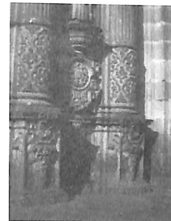
Detalle, columnas tritóstilas (primer nivel).
