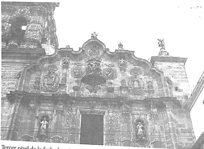
Tercer nivel de la fachada principal.
