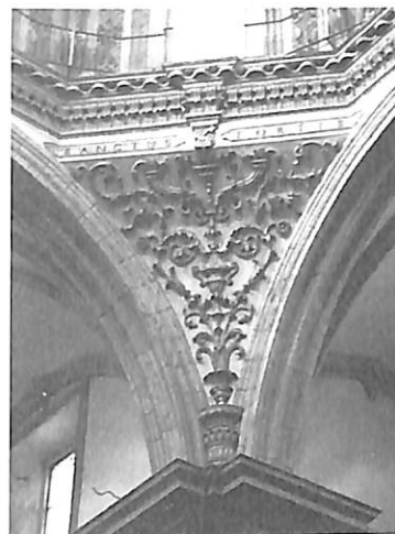
Detalle. Pechina de arranque de la cúpula en el crucero.
