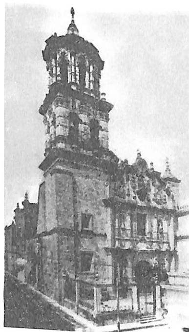
Niveles y calles en la fachada.
