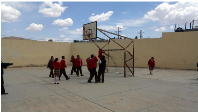
Imagen 3. Deterioro de la cancha de una Escuela Secundaria Técnica
