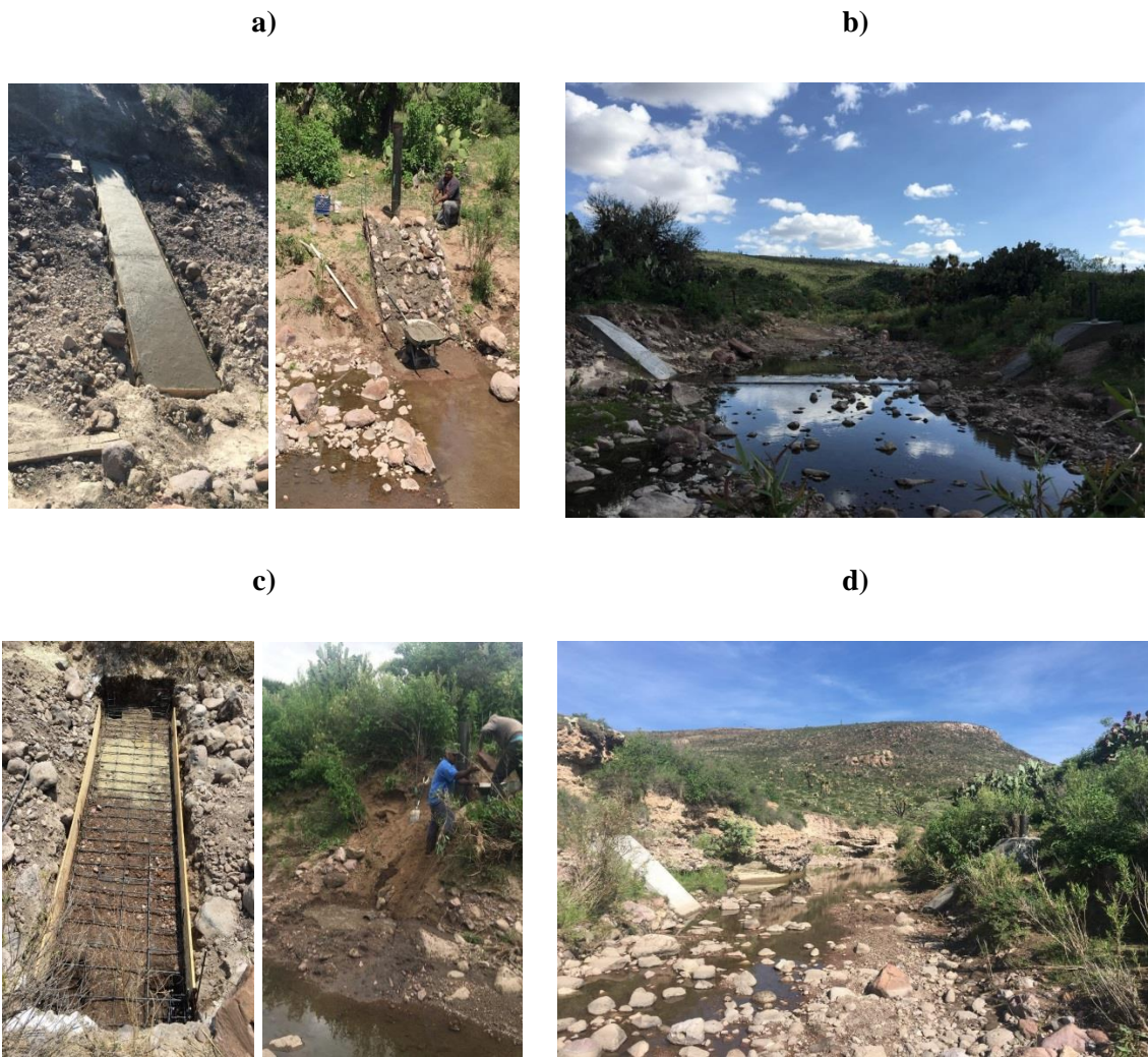
Figura 11. Proceso constructivo del vertedor 1 (a) y fotografía del resultado final (b) así como el proceso constructivo del vertedor 2 (c) con su resultado final (d)
