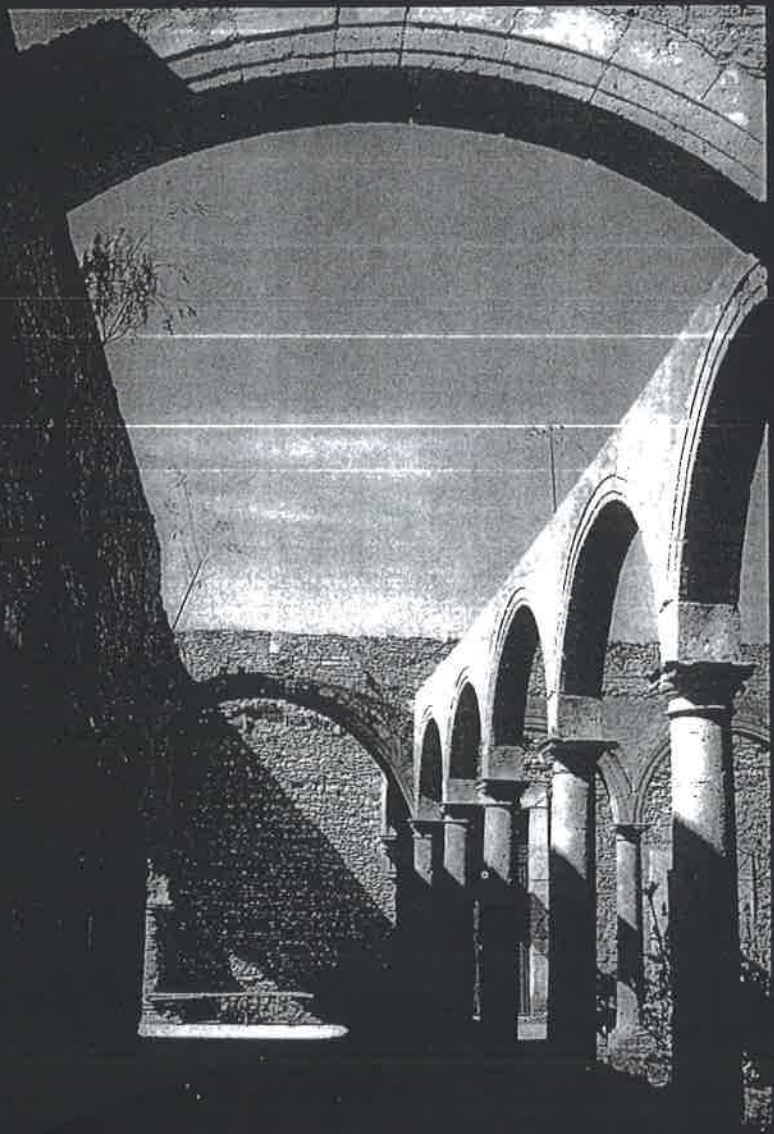
Parte de la casa grande, corredor del lado sur (HES).
