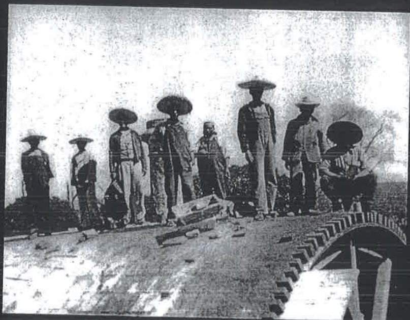
Reparando las galerías II (HSM).
