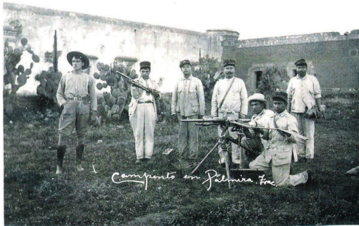
IMAGEN 1. CAMPAMENTO EN LA ESTACIÓN DE PALMIRA, ZACATECAS
