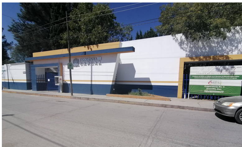
Figura 2. Fachada de la Unidad Académica Preparatoria de la UAZ - Programa III
