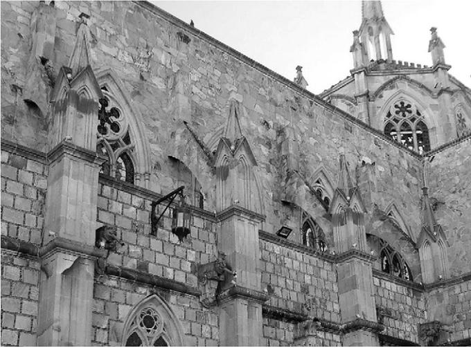
Ilustración 6. Arbotante y contrafuerte.
