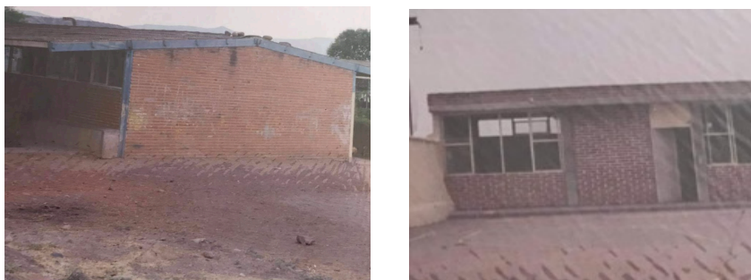
Imagen 10. Construcción de los salones de la secundaria '20 de noviembre'
