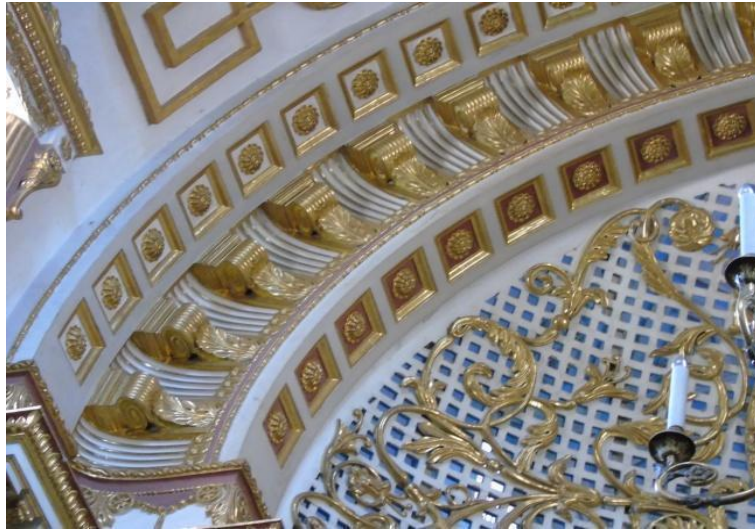
Ilustración 5: Detalle del arco fajón en la bóveda sur, se aprecian los modillones y casetones como elementos ornamentales. Fotografía: Irving Reyes Maldonado.
