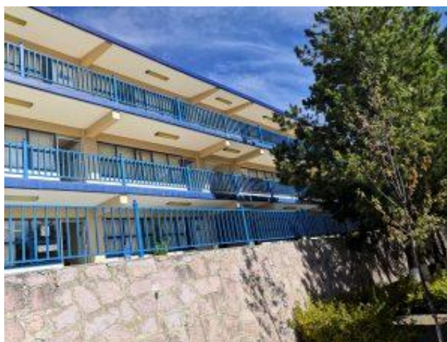
FIGURA 2. EDIFICIO DE SECUNDARIA.
