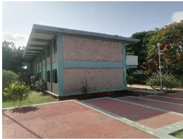
Edificio 2 Aulas de clase
