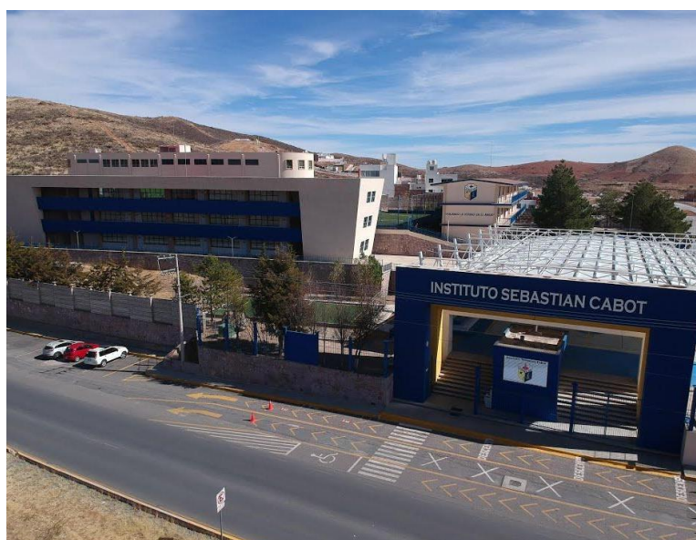
Figura 1. Fachada del Instituto Sebastián Cabot.
