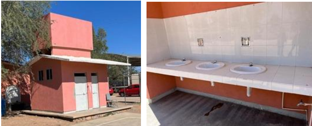
Imagen 12. Sanitarios de telebachillerato de Cerrito de la Cruz
