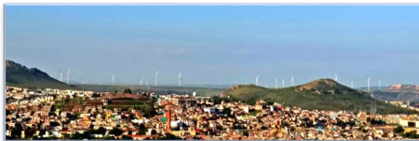
Aerogeneradores en el ejido El Orito, Zacatecas. Foto: La Jornada Zacatecas. Fuente: https://www.evwind.com/2017/08/26/eolica-en-mexico-proyecto-en-zacatecas/
