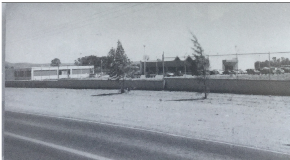
Imagen 2. Vista de los primeros edificios de la UTNA, (2003).
