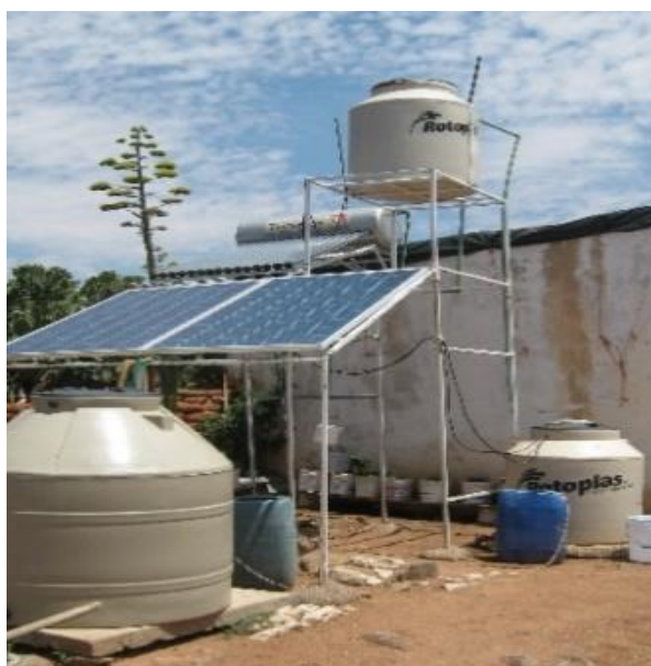
Figura 5. Estructura de soporte, paneles solares, calentador de agua solar y tinacos
