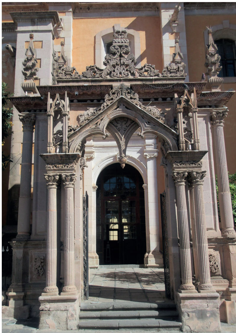
Anexo 6: Pórtico de acceso norte, se evidencia el uso de reminiscencias moriscas con los arcos conopiales, así como el uso de esferas como detalles para las cornisas. Irving Reyes Maldonado, 2023.
