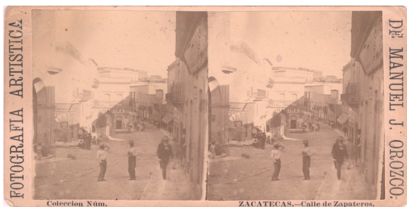
Fig. 2: Vista de la calle de los Zapateros. Ca. 1880. Col. Federico Sescosse Leujene, Biblioteca Camino Real de Tierra Adentro, Centro INAH Zacatecas. Del lado izquierdo se observa el Portal de Rosales, en segundo plano el inmueble que se encuentra entre la esquina de la calle de Zapateros y la desaparecida Plaza de San Agustín.
