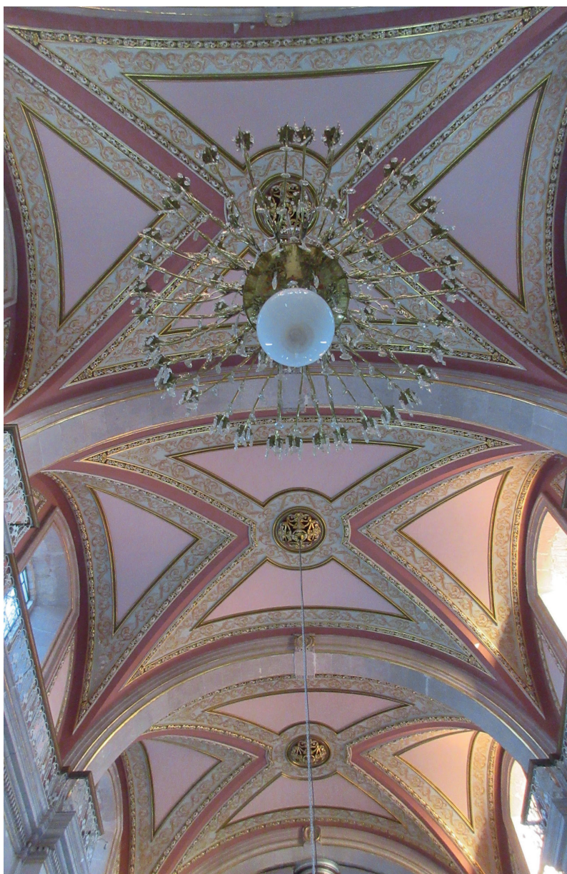
Anexo 15: pintura en las bóvedas del crucero. Irving Reyes Maldonado, 2024.
