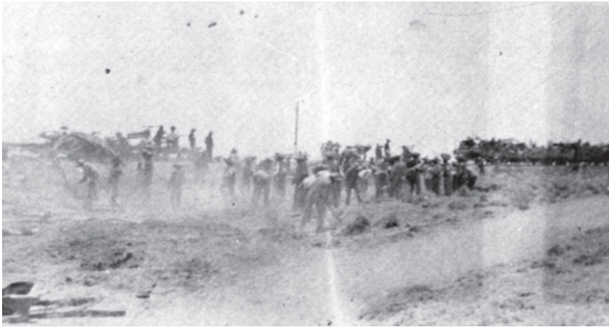
Reconstrucción de la vía de ferrocarril de la población de Calera de Víctor Rosales.
