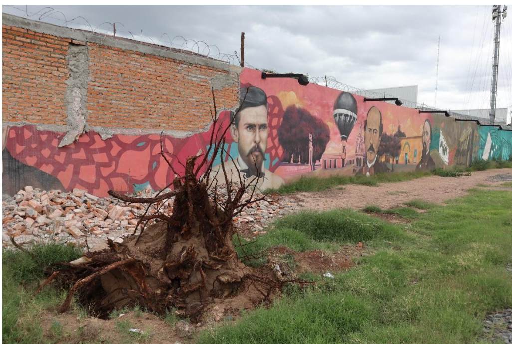
Imagen 2 Fotografía del mural posterior al derrumbe, 2023.
