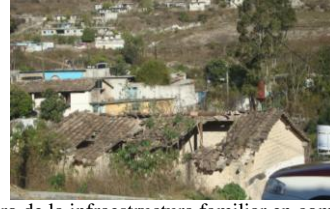
Deterioro de la infraestructura familiar en comunidades migrantes, San Miguel Tlacotepec, 2012.
